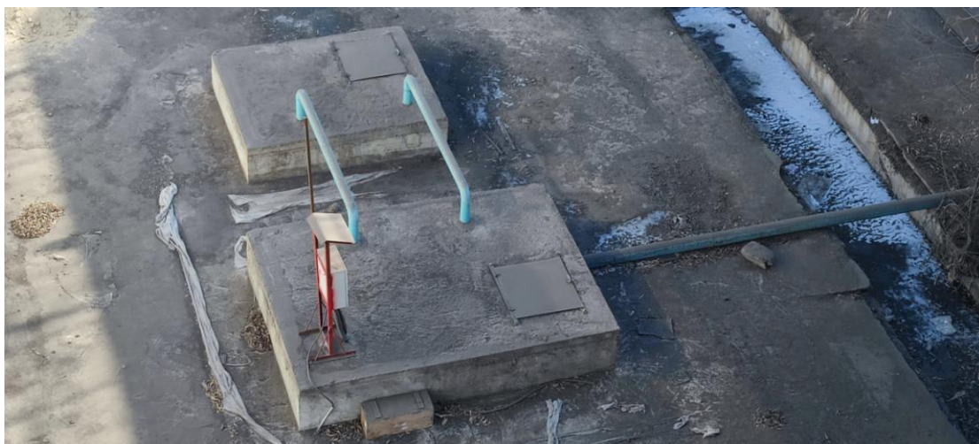
淋溶液集水池
