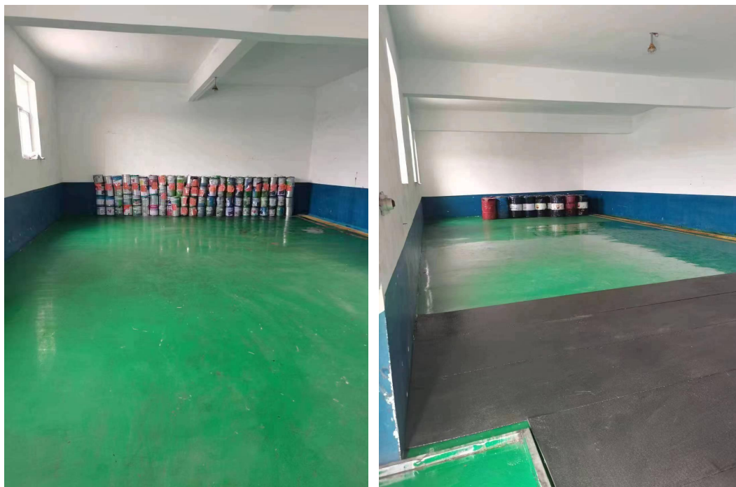
危险废物暂存间内部
